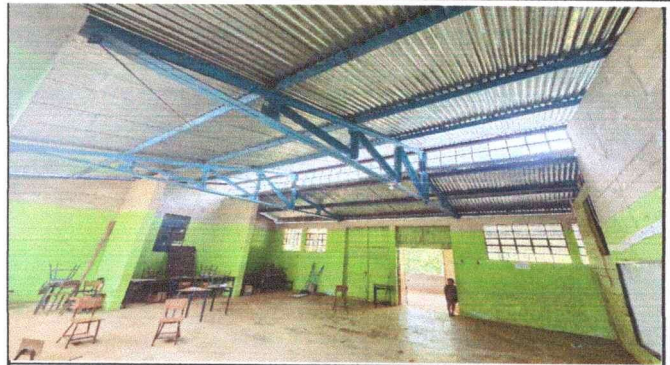
Foto 2: Mantenimiento de estructura metálica en aulas
